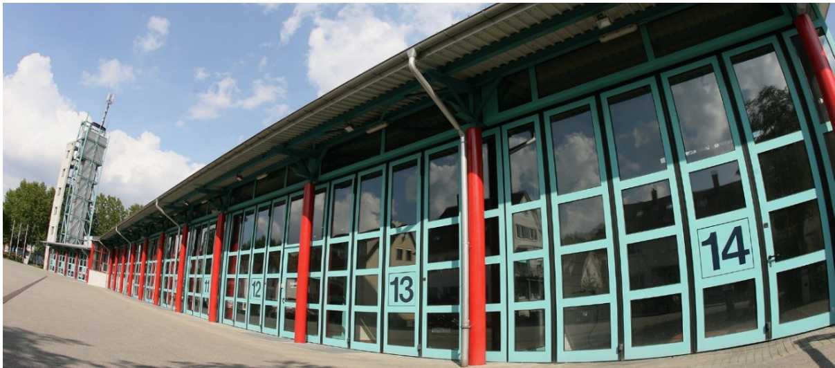
Abbildung 11: Das Pfullinger Feuerwehrhaus
