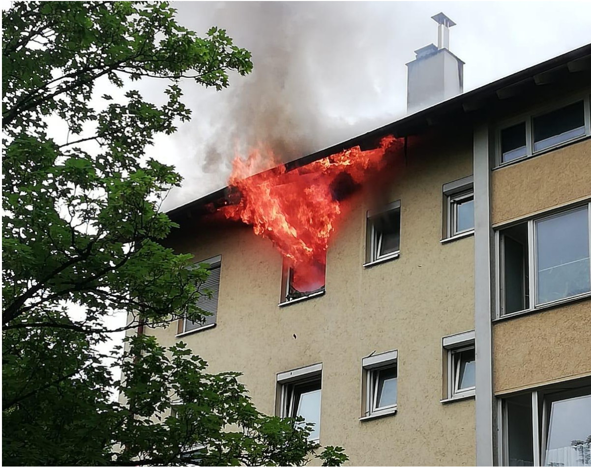
Abbildung 23: Küchenbrand mit drohendem Flammenüberschlag
